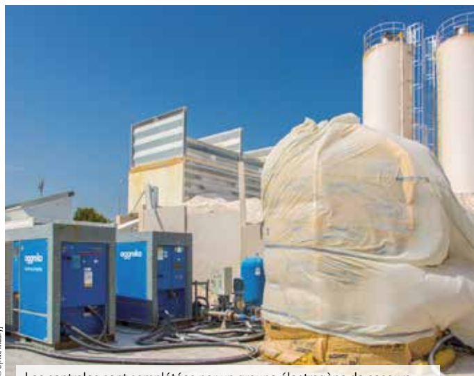
Les centrales sont complétées par un groupe électrogène de secours, afin d'assurer une production d'eau froide à une température de 3 à 4 °C.
