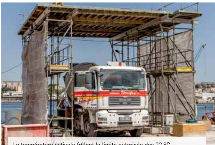
La température estivale frôlant la limite autorisée des 32 °C pour le coulage, la vidange des toupies se fait à l'ombre et un brumisateur de surface prévient des risques d'évaporation.
